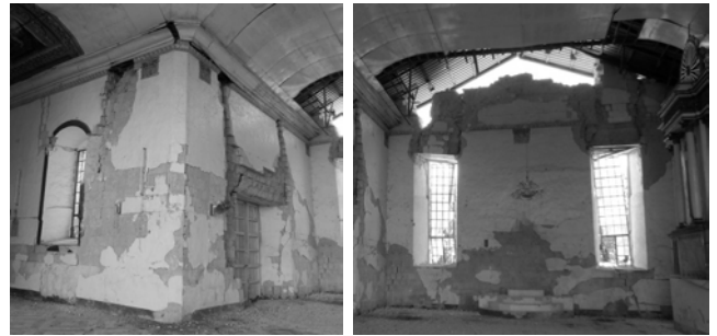
(c) 開口部周囲での破壊
