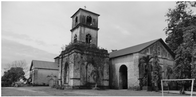
写真1 被災前の外観写真（南東より撮影）
